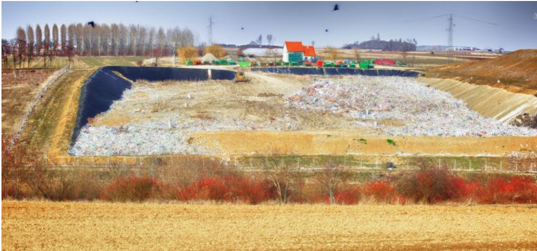
Slika 2. Odlagalište komunalnog otpada Vitika.
